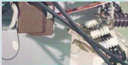
Кабельный отсек
