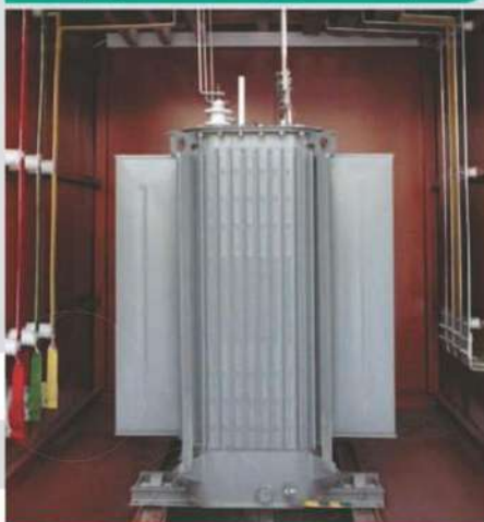
Трансформаторный отсек
