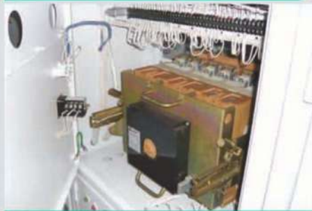
Отсек вводного выключателя
