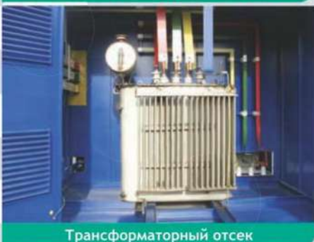
Трансформаторный отсек
