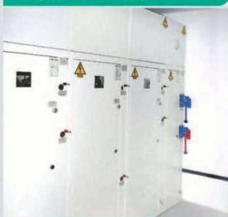
Распределительное устройство 10 кВ
