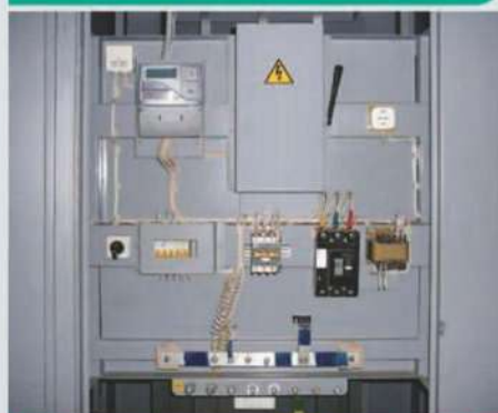
Распределительное устройство 0,4 кВ
